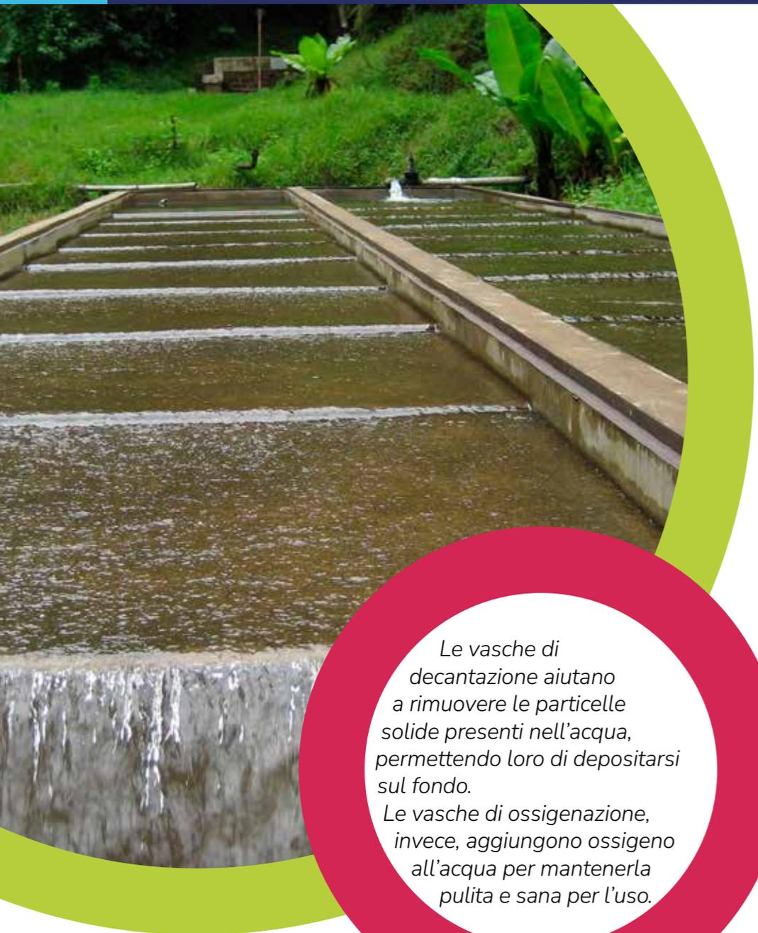
*Le vasche di decantazione aiutano a rimuovere le particelle solide presenti nell'acqua, permettendo loro di depositarsi sul fondo.*
