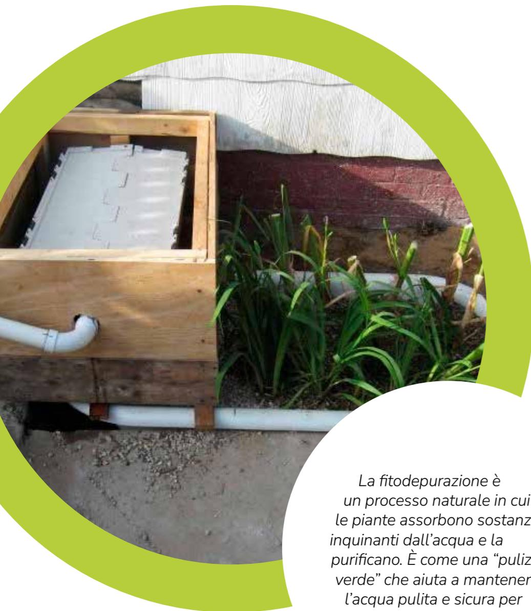
*La fitodepurazione è un processo naturale in cui le piante assorbono sostanze inquinanti dall'acqua e la purificano. È come una "pulizia verde" che aiuta a mantenere l'acqua pulita e sicura per l'ambiente.*
